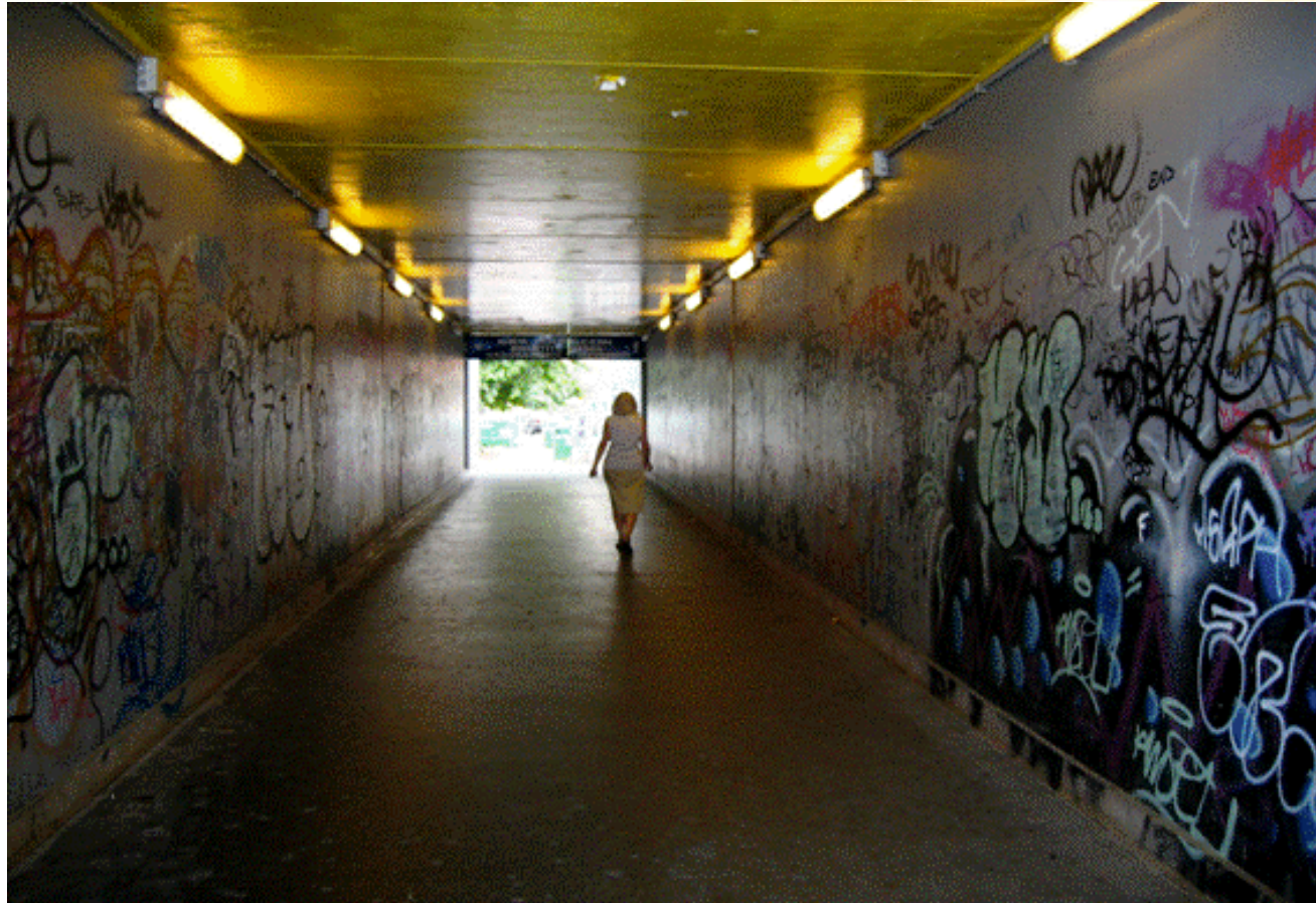
Unterführung bei einer Haltestelle in Erfurt
